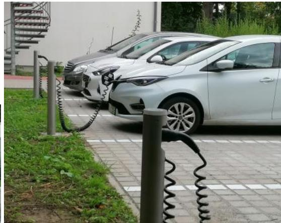
Ein Lastmanagement sorgt dafür, dass der Anschluss nicht überlastet wird und dennoch am nächsten Morgen alle Autos wieder einsatzbereit sind.
